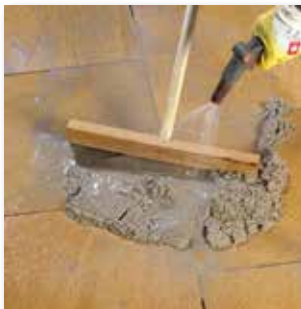
Einarbeiten mit Hartgummischieber und Wassersprühstrahl
