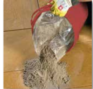
Portionsweises Aufbringen des Fugenmörtels
