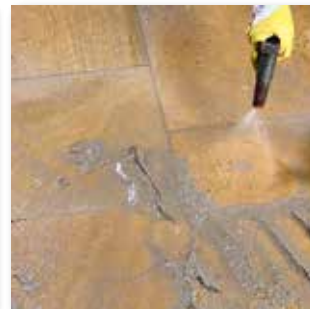
Reinigen der Oberfläche mit weichem Wassersprühstrahl
