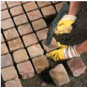
Pflaster hammerfest setzen
