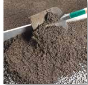
Mörtel aufbringen und über Lehren abziehen
