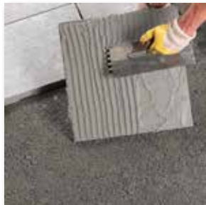
Bei Platten unterseitig bauline Universal-Haftbrücke auftragen
