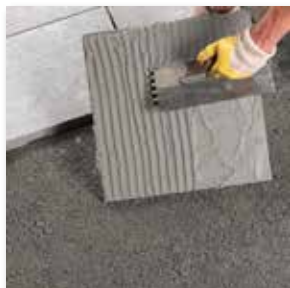
Bei Platten unterseitig bauline Universal-Haftbrücke auftragen
