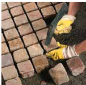
Pflaster hammerfest setzen
