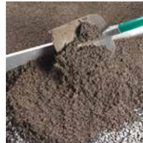
Mörtel aufbringen und über Lehren abziehen
