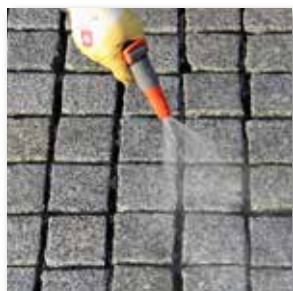
Flächen rückstandsfrei reinigen, Fläche vornässen
