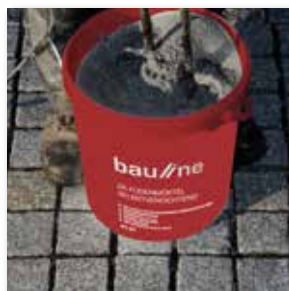
Bindemittelflasche entnehmen und Harz/Sandgemisch vormischen
