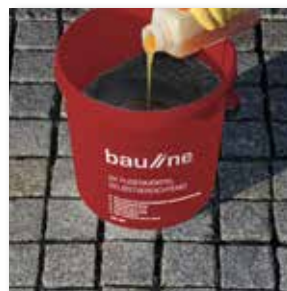
Bindemittelkomponente zugeben
