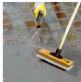
diagonal zur Fuge abreinigen
