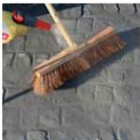
Erhärten des Mörtels auf der Oberfläche vermeiden
